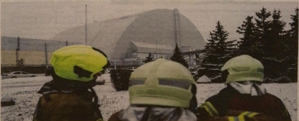
PERISAI keselamatan di reaktor nuklear Chernobyl mengalami kerosakan teruk akibat serangan dron menyebabkannya tidak lagi mampu mengawal pelepasan radiasi. - AGENSI
